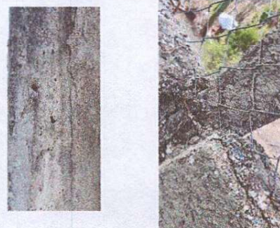
Foto 2: Reparación repello y tallado de las 2 hiladas de block y de columnas
