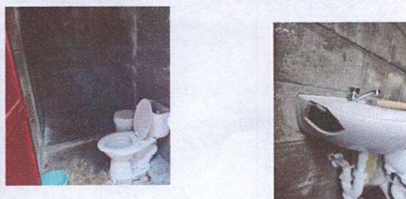
Foto 5: Sustitución de sanitario y lavamanos
