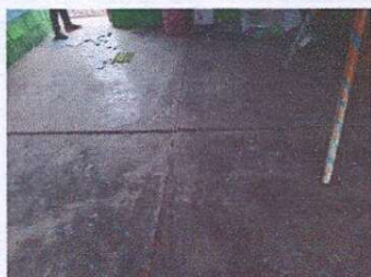
Foto 3: Reparación de piso de aula por levantamiento
