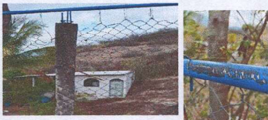
Foto1: Sustitución de maya por maya ciclonica tensada
